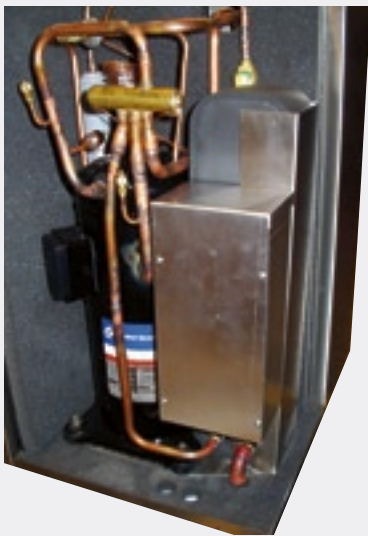
Die Anschlussbox für das Steuersystem in seiner besonderen Konstruktion mit doppelter thermischer Länge sowie den optimierten Scrollkompressor. Man erkennt deutlich die durchdachte Verlegung der Rohre, u.a. zum Vierwegeventil.
